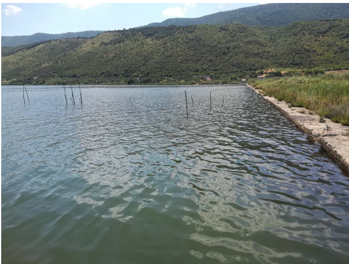
RIMOZIONE PALI AMMALORATI
